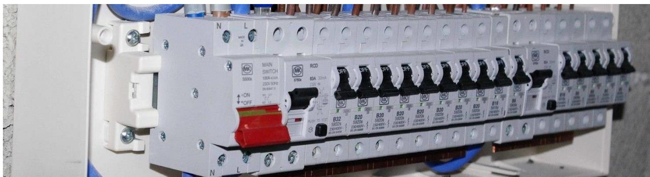
Un disyuntor es un interruptor automático que corta el paso de corriente eléctrica si se cumplen determinadas condiciones. Sirve para proteger a las personas y a los dispositivos eléctricos.
